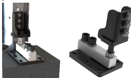
Figuras 5 e 6. Vista frontal e traseira do como devem ser fixados os parafusos no pé do silo.
